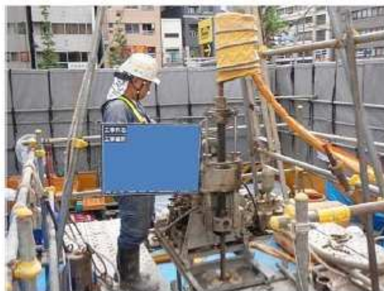
ボーリング調査の様子
