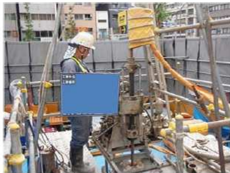
ボーリング調査の様子
